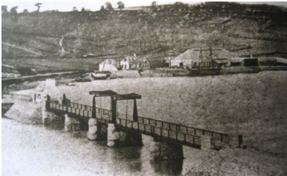
le premier pont avant réfection
