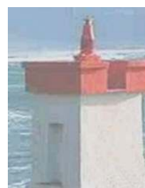
Le phare de Pors Poulhan, d'une hauteur de 6 mètres. Il est construit en béton armé et a été mis en service en juin 1927
