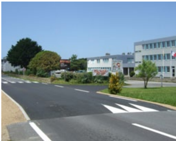
Les allées et venues aux abords du collège se font maintenant avec plus de sérénité.
