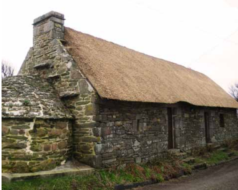
Photo ci-dessus : la nouvelle toiture de chaume de la maison à four de Kéristenvet
