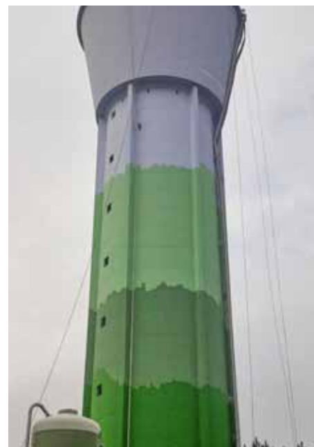
Photo ci-contre : le château d'eau en cours de réhabilitation
