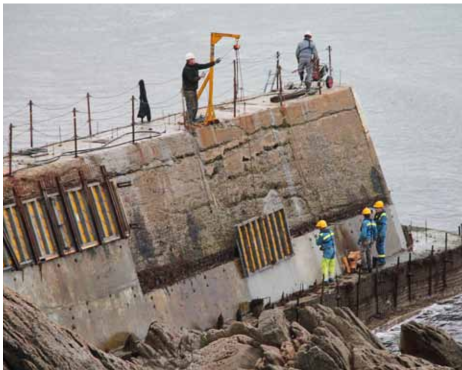
Photo ci-dessus : la digue sud-ouest de Pors Poulhan avait besoin d'un lifting
