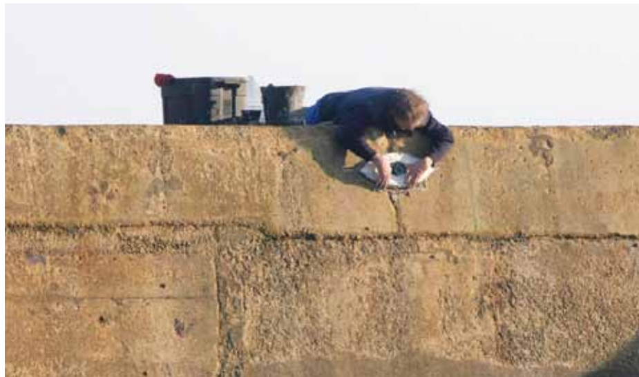
Photo ci-dessus : Pierre Chanteau a scellé un œil en verre et en faïence sur la digue de Pors Poulhan
