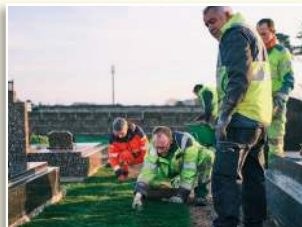
↑ Pose des plaques d'enherbement
