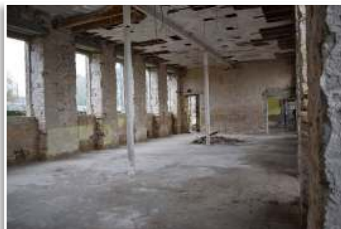
↑ Intérieur de la Mairie (finalisation en 2022).
