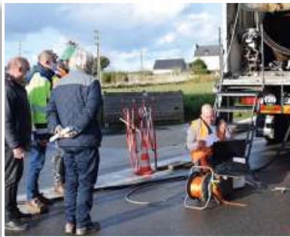
↑ Remise en service des branchements via robot placé sous contrôle vidéo.
