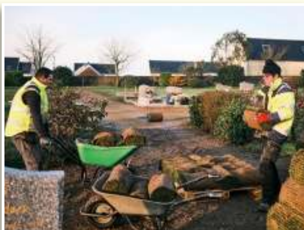
↑ Préparation pour la pose des plaques herbées
