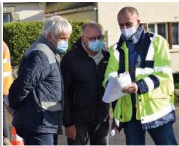
↑ Assainissement des réseaux, Chemin de la Corniche.
