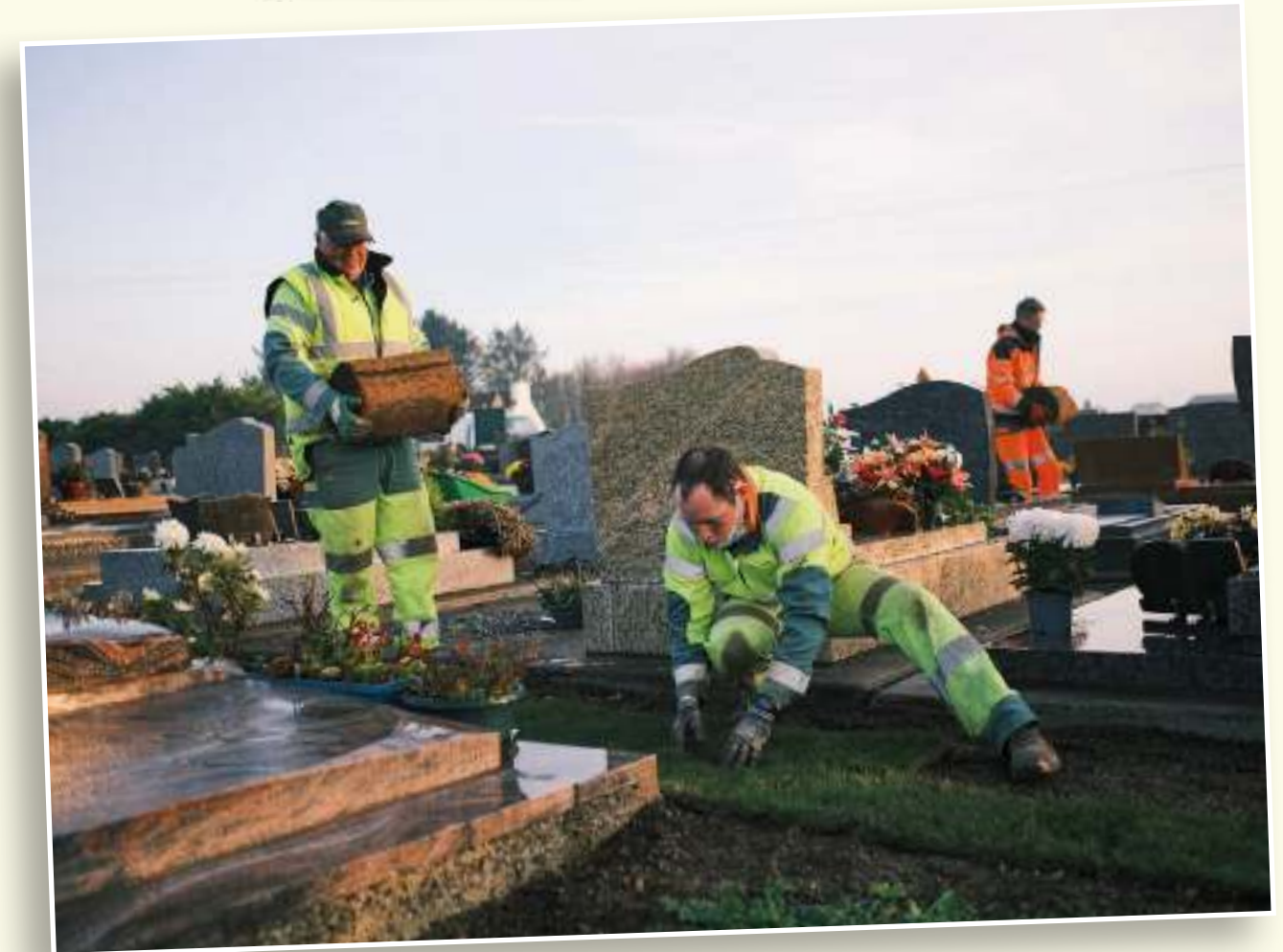
↑ Pose dans les allées de plaques d'enherbement
