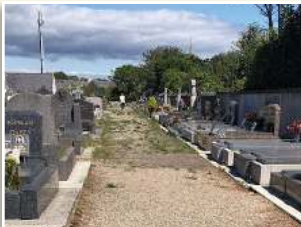
↑ Le cimetière avant travaux
