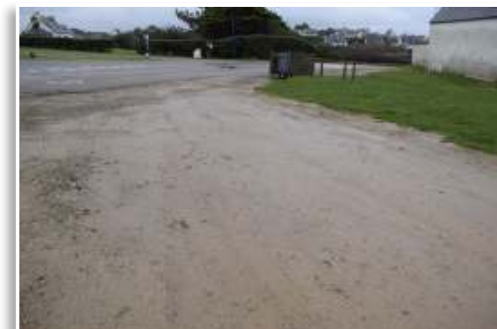
↑ Réfection du parking Gored.
