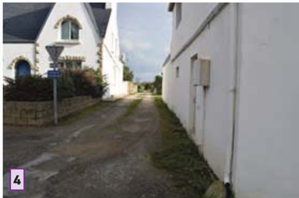
↑ Chemin de Kerguelen, avant travaux de réfection
