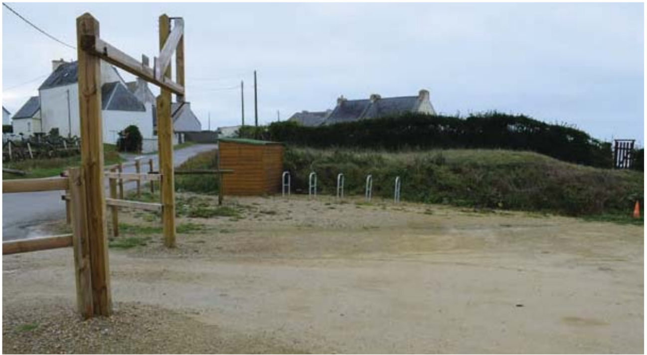
↑ Réfection et aménagement du Parking du Gored pour les véhicules légers
