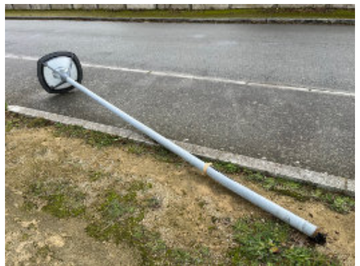
Lampadaire à terre rue du 11 Novembre
