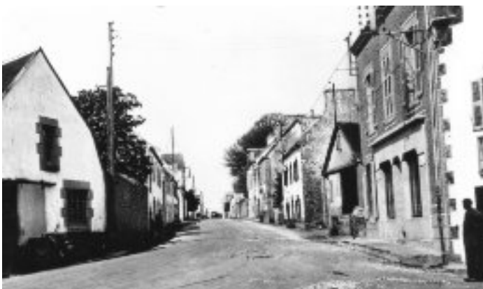
Années 50 : pas de caniveau, pas de trottoir. Une route rafistolée à partir de tas de cailloux et des traces laissées par le passage des chevaux. Les maisons de Kerfily Creis sont remplacées par les hangars à charbon de René Bosser.
