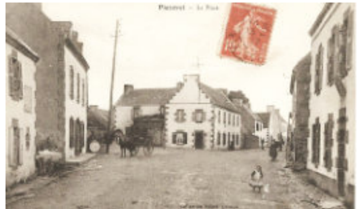
Vers 1910 : la ligne électrique alimente Audierne... mais elle ne fait que passer... Les chaumières de Kerfily Creis sont encore debout et la maison, au fond, n'a pas encore été transformée.
